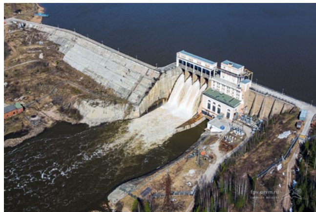
Рис. 4. Широковская ГЭС. Годы строительства: начало - 1942 г., ввод агрегатов 1947...1948 гг.
