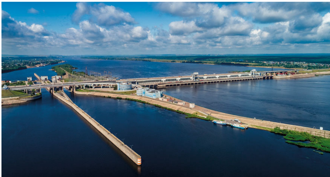
Рис. 5. Нижнекамская ГЭС. Годы строительства: начало – 1963 г., ввод агрегатов 1979...1987 гг.
